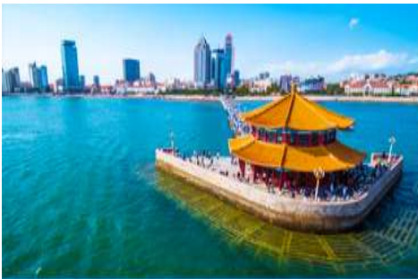
สะพานจ้านเฉียว
